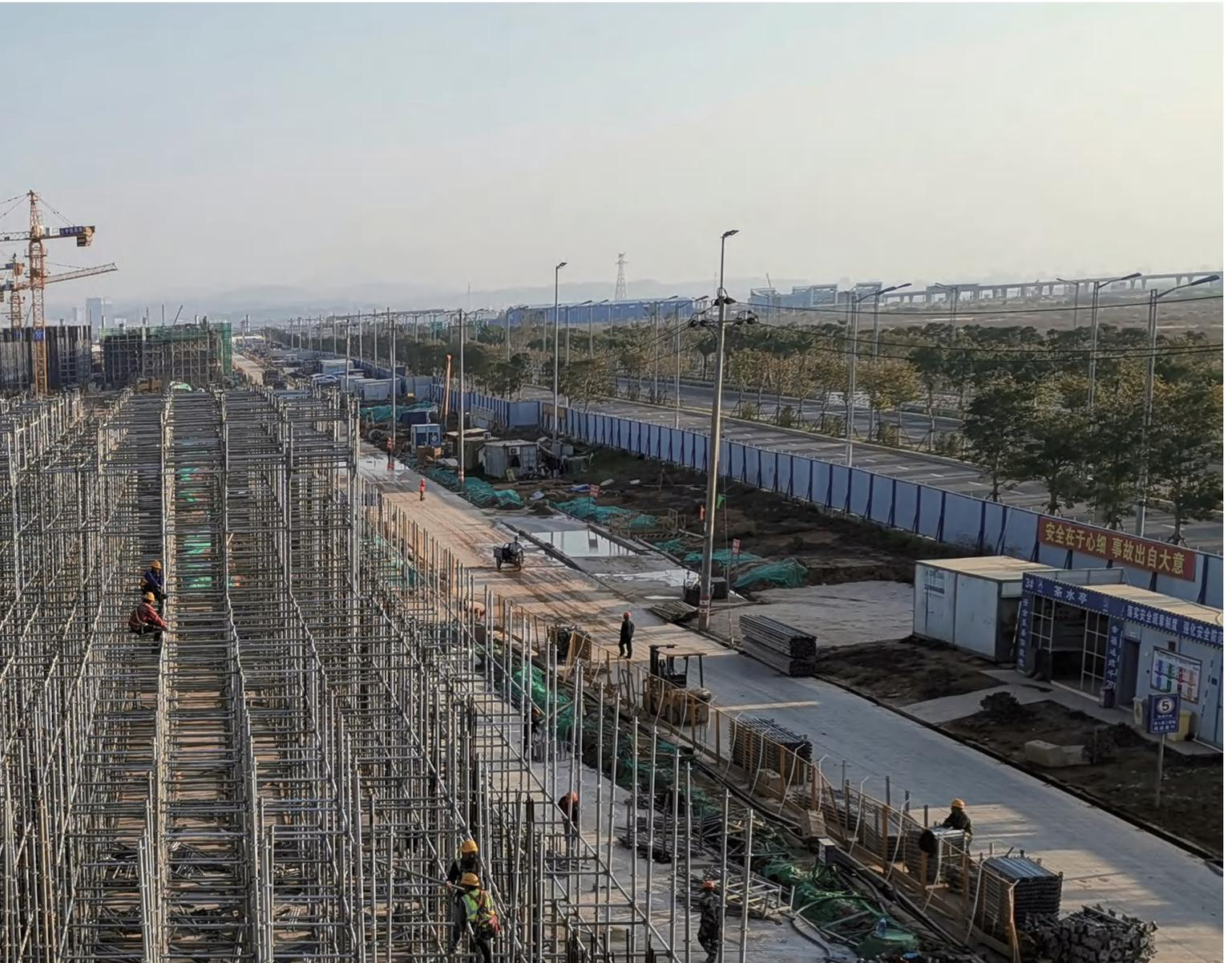
城市軌道交通對提升城市公共交通供給品質和效率、緩解城市交通擁堵、引導優化城市空間結構佈局、改善城市環境起到了重要作用。目前，開通軌道交通線路的城市越來越多，城市軌道運營里程逐年攀升，線網規模也逐年擴大。而土地資源的稀缺性使地鐵車輛段的設計轉向多功能大型綜合體的模式，盤扣式高大支模體系和專業承包成為此類專案上的剛需。
