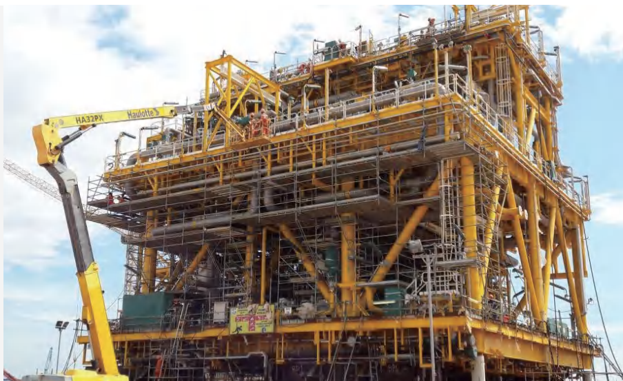
工业模块和造船 场内和海上平台项目
